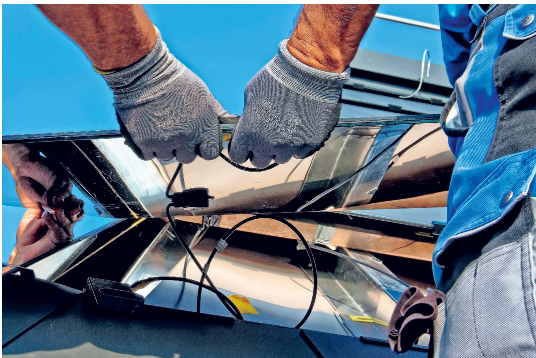
Montering av solpaneler. Foto: Ricardo Gomez Angel
